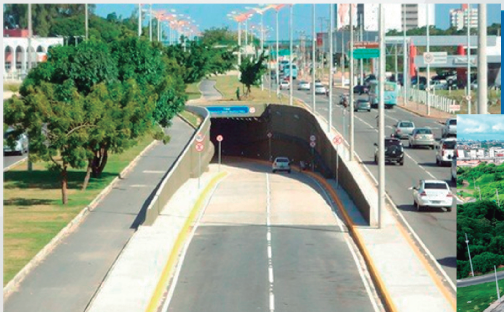
Túnel do Centro de Convenções de Fortaleza
